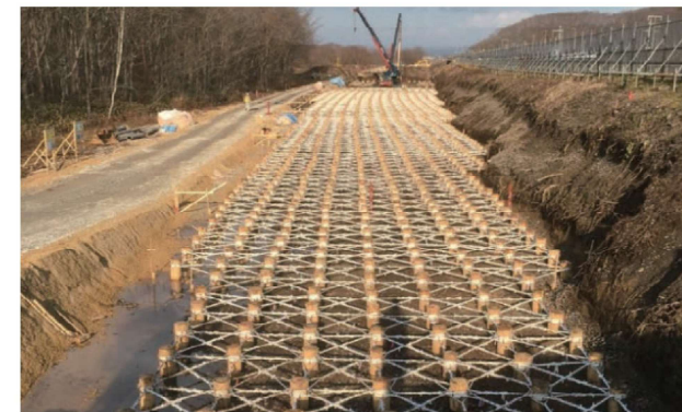
杭間連結状況
